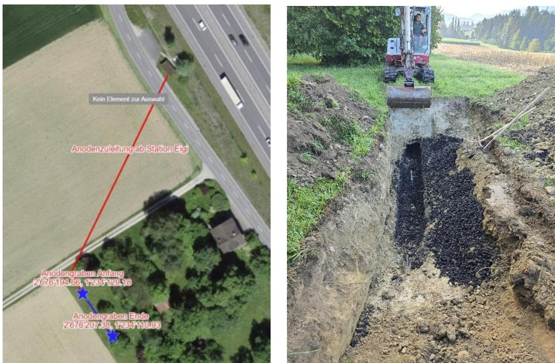
Abbildung 6: Situation und freigelegte Anode
